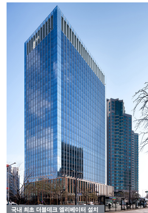
국내 최초 더블데크 엘리베이터 설치
